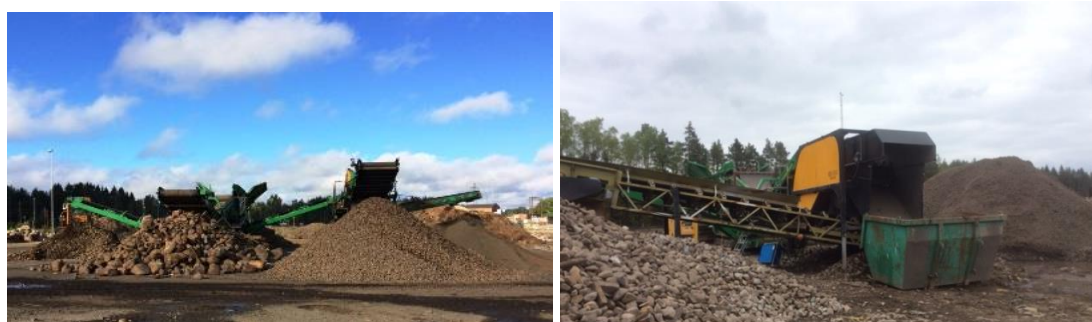
Figur 5-5. Steg 1 till vänster, två skaksikt som delar in massorna i fraktionerna 0-20 mm, 20-50 mm, 50-100 mm, >100 m. Steg 2, vindsikten till höger. Stenen kommer ut på transportbandet underifrån och slippersrester samt slagg i den gröna containern.
